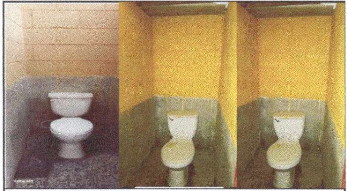
Foto 7: Mejoramiento de sanitarios en un 15% de avance.
