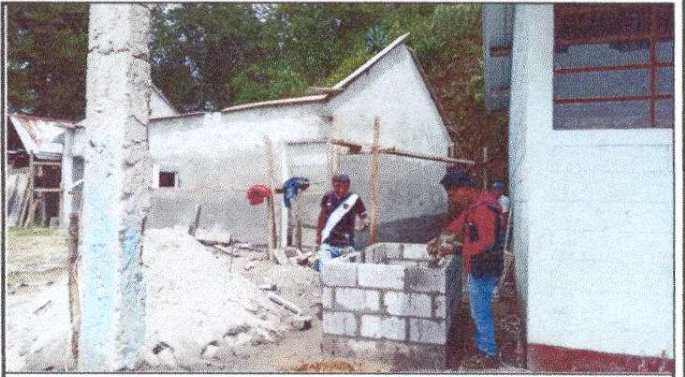
Foto 8: Sustitución de pila en un 25% de avance.
