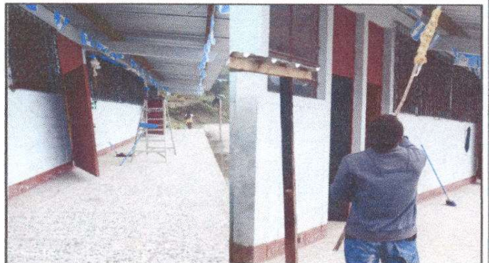
Foto 4: Pintura externa del edificio escolar en un 5% de avance.
